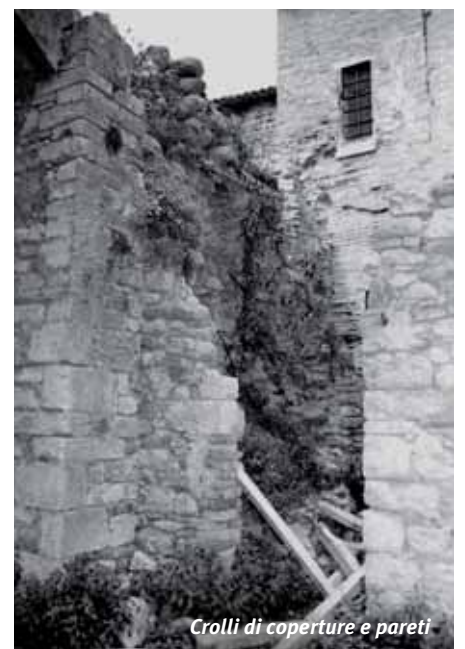
Colombaia con vistose lesioni alle pareti
