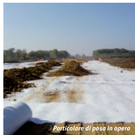
Particolare di posa in opera
