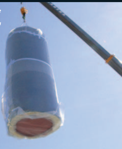
Accumulatore solare da 10.000 litri posato con l'autogru prima della posa del tetto
