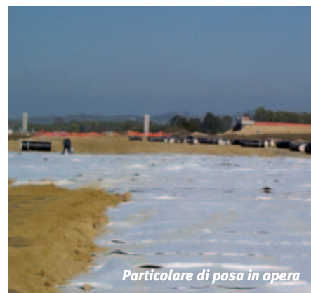
Particolare di posa in opera
