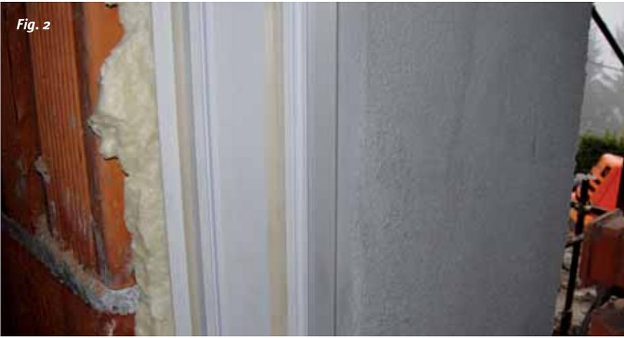
**Fig. 2:** il falso telaio isolato è adatto anche per la ristrutturazione di edifici esistenti.
