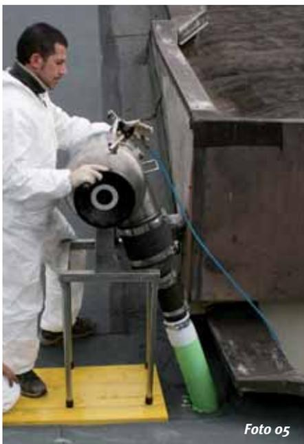
**Il nuovo tubo arriva in cantiere sotto forma di tubolare flessibile costruito con leggerissimo feltro o tessuto poliestere. Raggiunta la completa polimerizzazione della resina il tubolare flessibile diventa un nuovo tubo rigido, geometricamente e chimicamente aderente alle pareti del vecchio tubo, perfettamente impermeabile e resistente sia dal punto di vista chimico che fisico**
