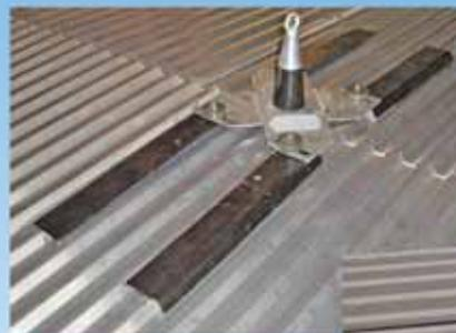
Versione per il colmo delle coperture grecate.
