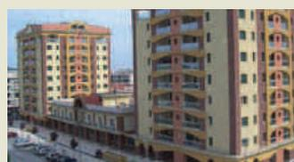
garantire un sistema di isolamento termico ottimale. La finitura degli edifici è stata eseguita con intonachini di tipo silossanico e mattoncini a vista Meldorfere.
