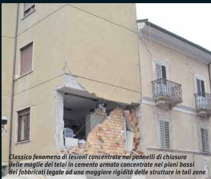
Lesione del pannello murario in corrispondenza degli elementi più deboli compresi tra le aperture delle finestre
