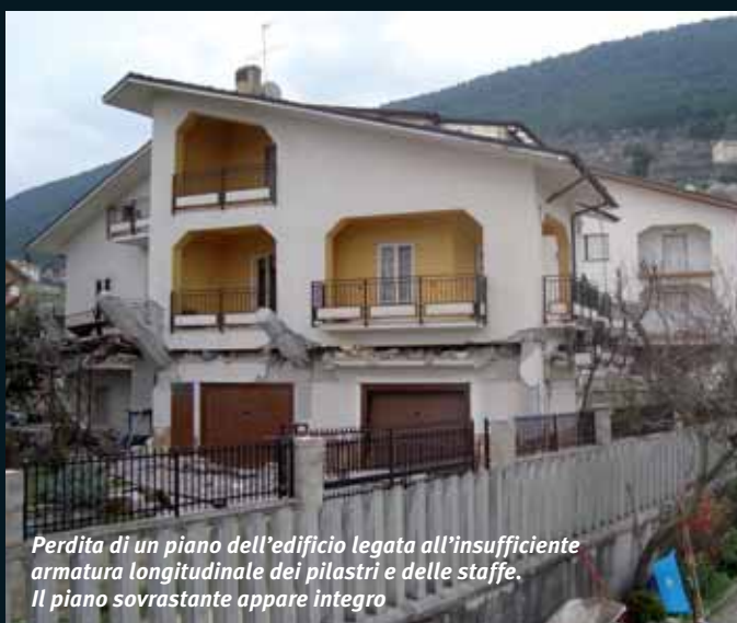
Classico fenomeno di lesioni concentrate nei pannelli di chiusura delle maglie dei telai in cemento armato concentrate nei piani bassi dei fabbricati legate ad una maggiore rigidità delle strutture in tali zone
