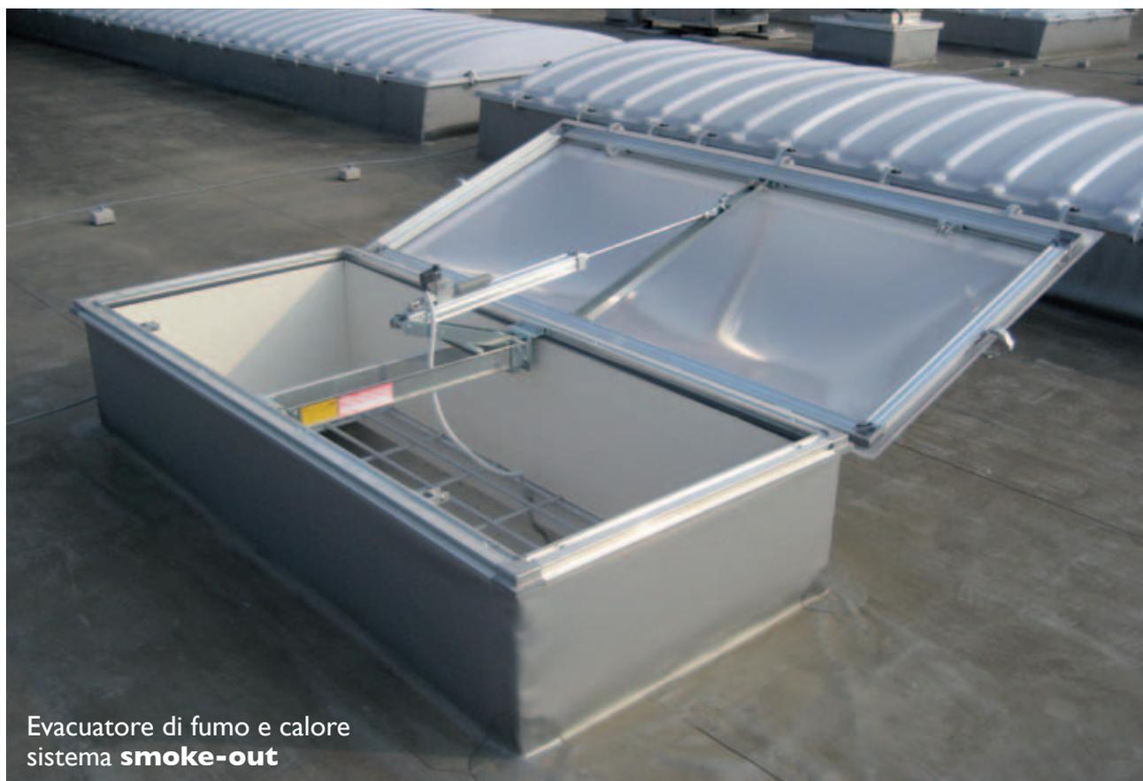
Evacuatore di fumo e calore sistema **smoke-out**
